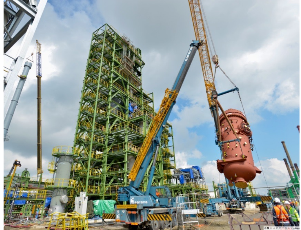
Erection PDQ Gasifier, Dunkirk
